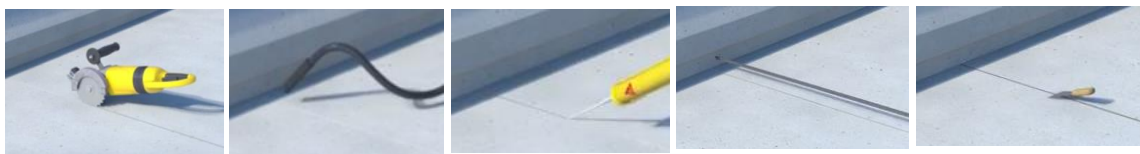
Fig 7. Pemasangan CFRP NSM
