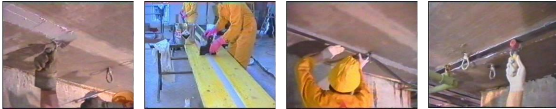
Fig 5. Pemasangan CFRP Plate
