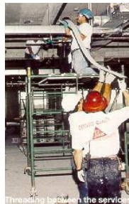
Fig 4. Pelaksanaan CFRP tanpa pembongkaran plumbing
