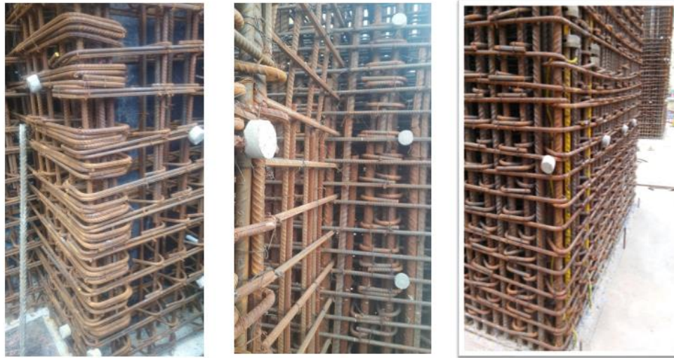
Gambar 4 Tulangan kolom dan shearwall struktur gedung Thamrin 9 Tower 1 (desain awal non PBD)
