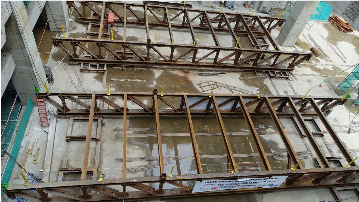
Gambar 10. Foto truss baja yang sudah dirangkai di lapangan
