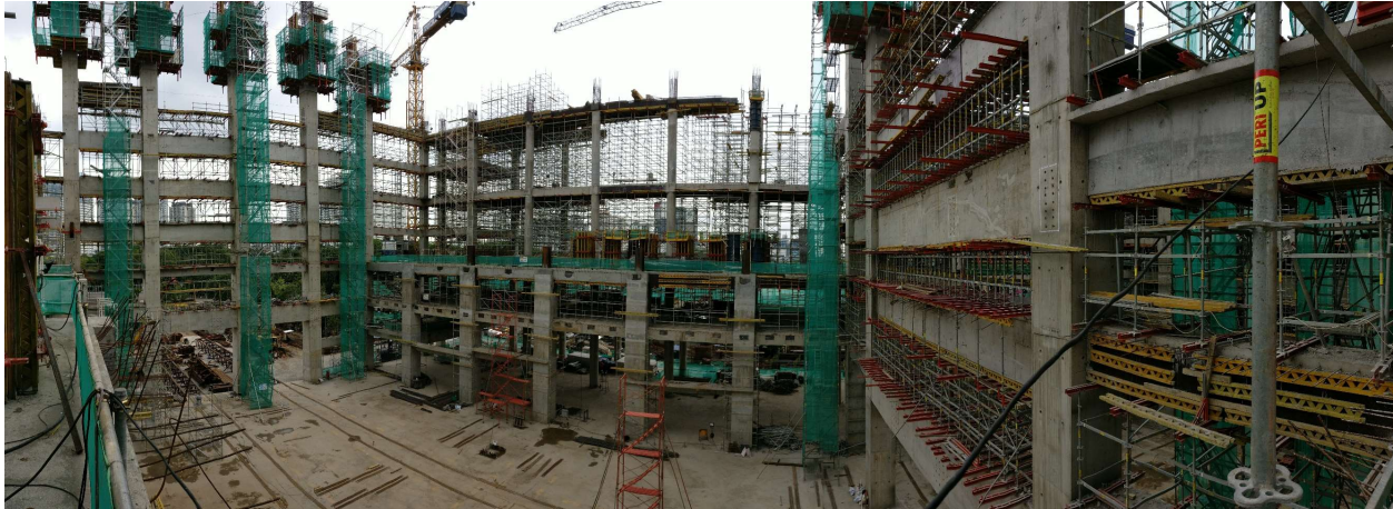
Gambar 12. Perimeter frame dengan kondisi kolom kantilever sebelum proses heavy-lifting truss
