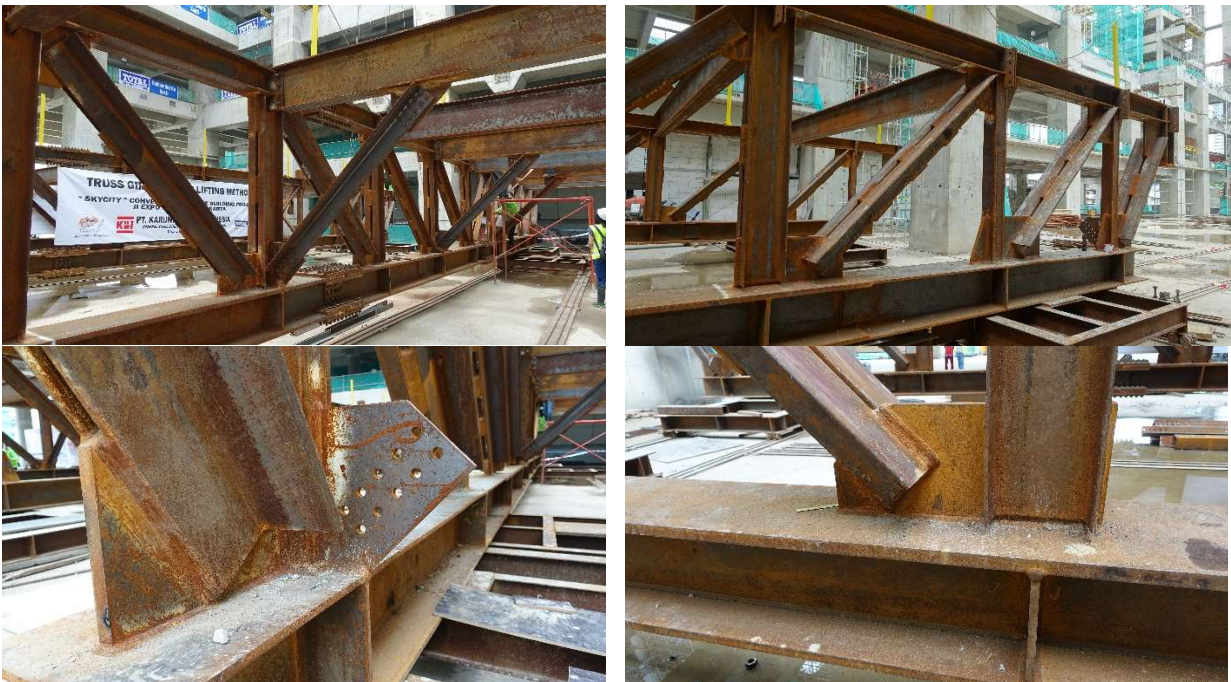
Gambar 9. Foto sambungan-sambungan truss baja gedung Sky City
