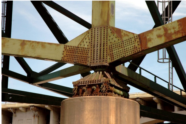
Gambar 11. Korosi pada jembatan I-35 (Sumber : en.wikipedia.org)
