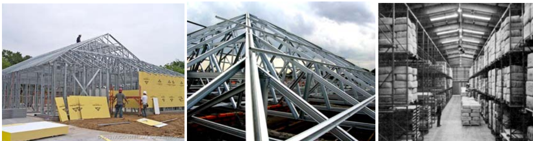
Gambar 23. Aplikasi struktur baja ringan atau baja cold-formed atau baja canai dingin (sumber internet)
