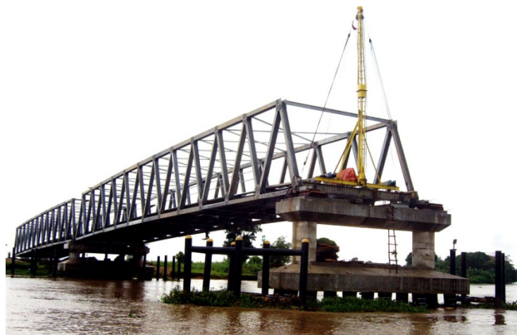
Gambar 28. Proses erection jembatan Berbak, Jambi (Sumber: L. Hidayat)
