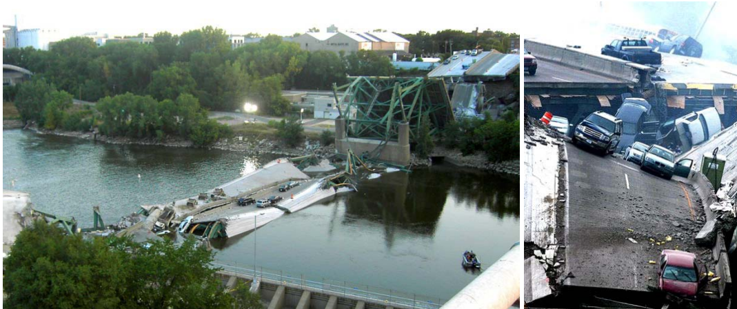
Gambar 10. Keruntuhan tiba-tiba jembatan berumur 40 tahun di Minnesota (2007)
