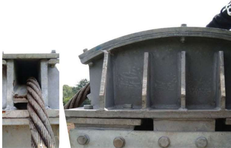
Gambar 50. Orientasi kabel terhadap tumpuan saddle , kasus Cirebon
