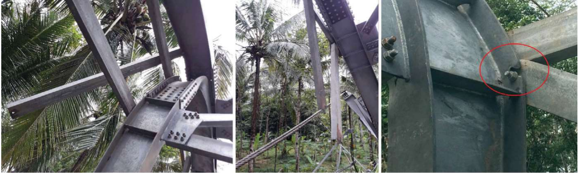
Gambar 42. Kondisi kerusakan sambungan bracing (Ref. Balai Besar VIII - PUPR)
